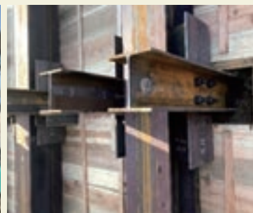
写真-3 抑止部材締結完了
