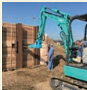
写真-2 抑止部材挿入状況
