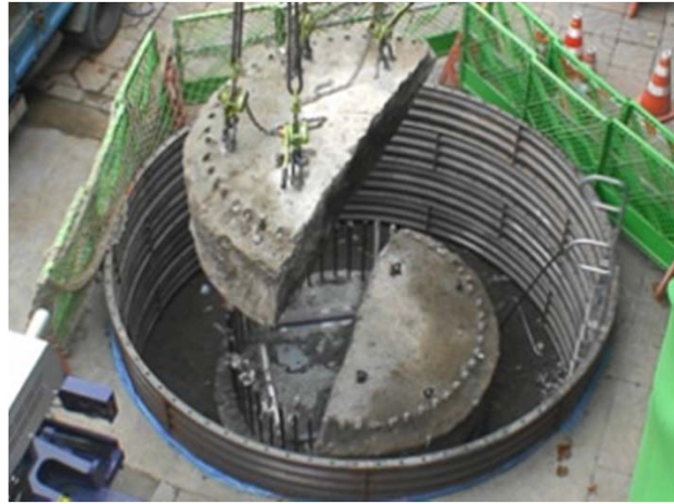
余盛コンクリート撤去状況
