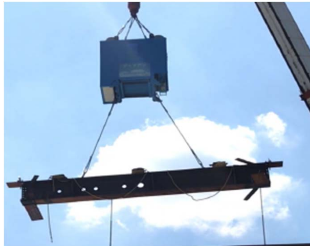
吊荷旋回制御装置の現場適用状況
