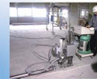
耐震補強用 鉄板取付けロボット
