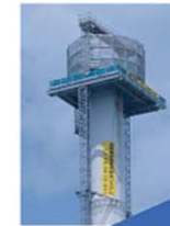
テムリス煙突解体
