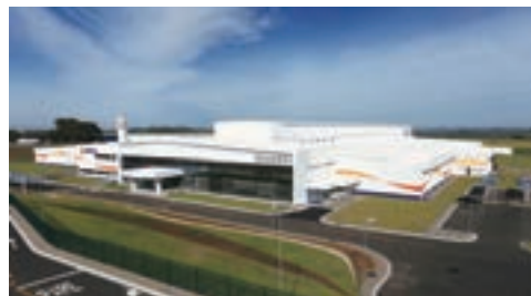
ユニチャーム ブラジル ジャグアアリウーナ工場 (2014年竣工:ブラジル)
