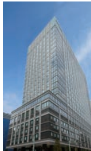
超高層オフィスビルへの導入事例 (京橋トラストタワー)
