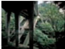
箱根バイパス天狗橋(1961年)
