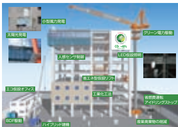
低炭素施工システム「TO-MINICA」イメージ図
