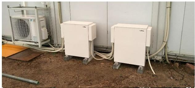
写真2 All-in-One蓄電池システム設置状況
