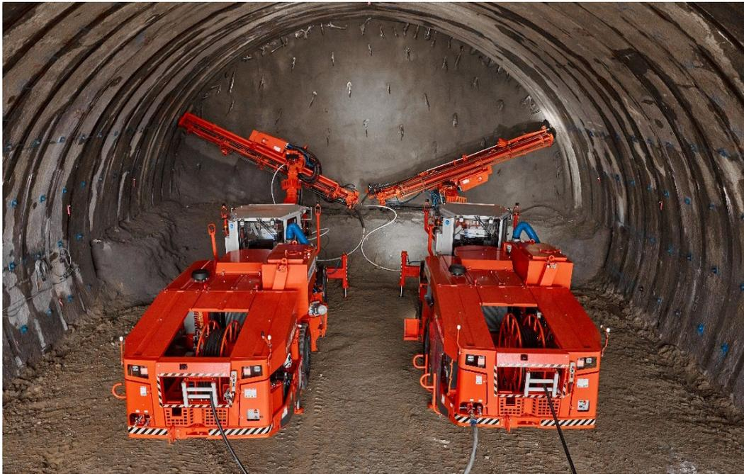
写真1 宇治田原トンネル東工事におけるロボルト施工状況
