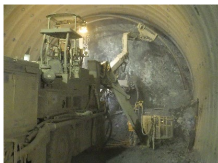
写真2 吹付けコンクリート施工状況
