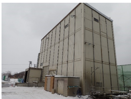
写真1 現場内のコンクリート製造設備
