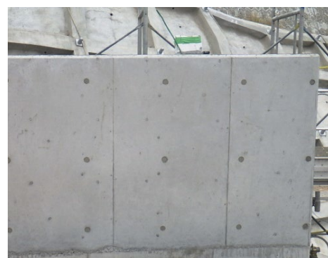
写真3 無機系短繊維補強 コンクリートの仕上がり
