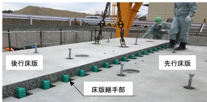
写真-1 架設状況
