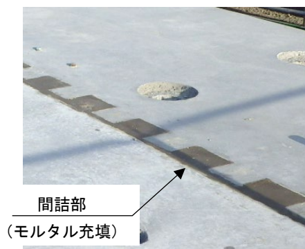
写真-2 間詰部モルタル充填状況
