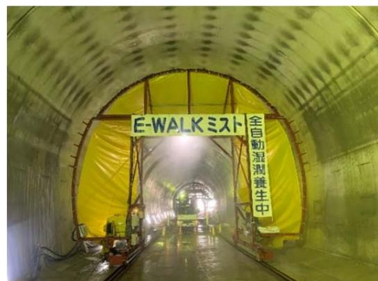
写真-1 E-WALKミスト稼働状況
