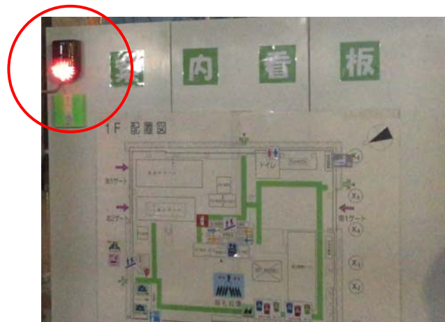
写真-4 避難階の案内看板に設置したパトライト（点滅した状況）
