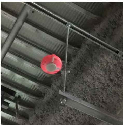
写真-1 吊ボルトを利用した感知器の設置状況
