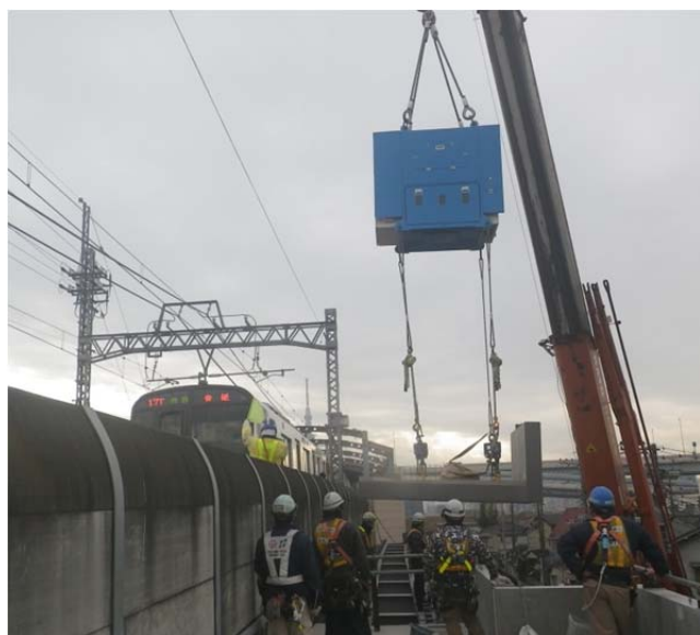
写真1 営業線の列車走行時の架設状況
