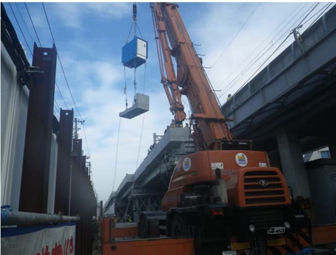
写真2 吊荷の旋回状況
