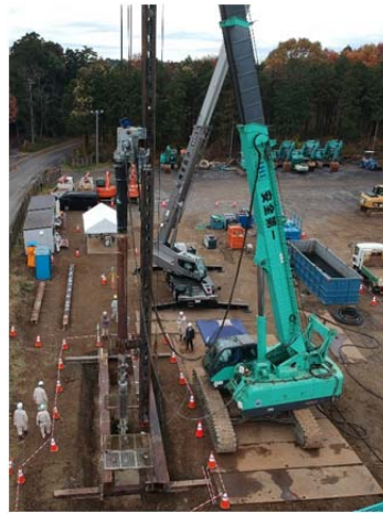
写真-1 固化工程専用機 写真-2 固化工程専用機先端部
