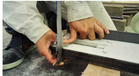
写真2 充填材表面の精度管理 拘束材コンクリート平滑度の施工精度 \pm 1\text{mm} を実現
