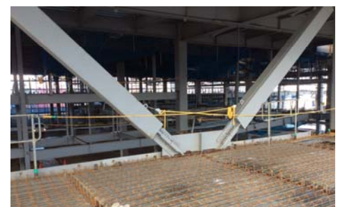
写真1 戸田式座屈拘束ブレース設置状況
