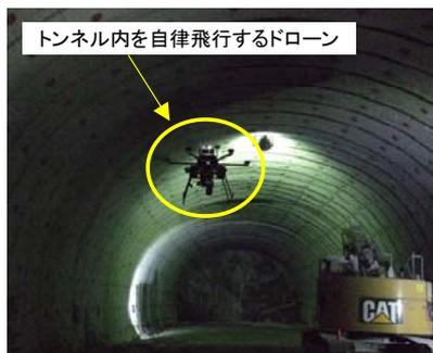
写真-2 トンネル内の自律飛行
