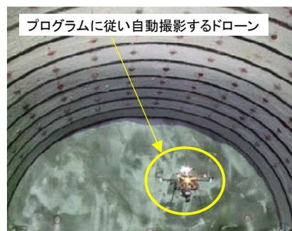
写真-3 切羽近傍の自動写真撮影
