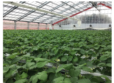
写真3 「SORAリウム」内部 (中柱の無い大空間構造)
