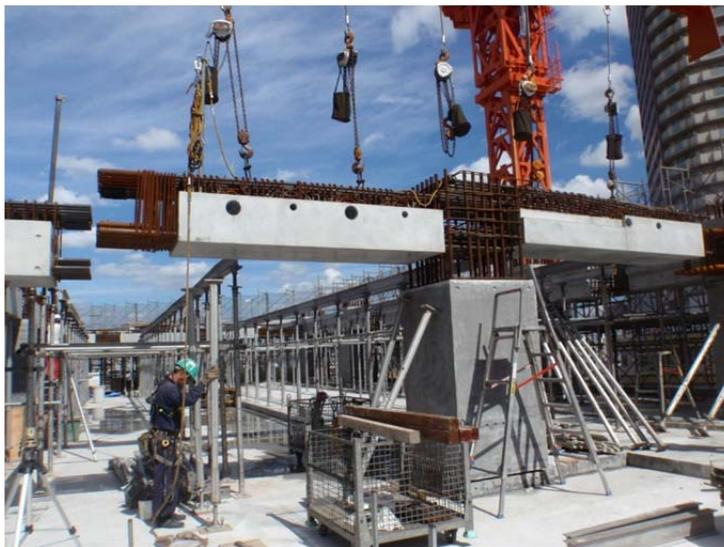
写真 プレキャスト鉄筋コンクリート梁の施工状況
