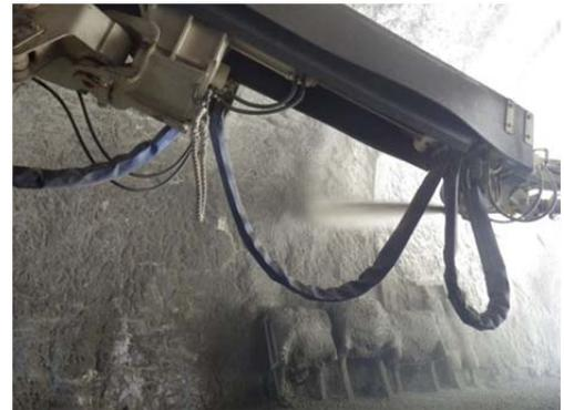
図2 コンクリート吹付試験の状況
