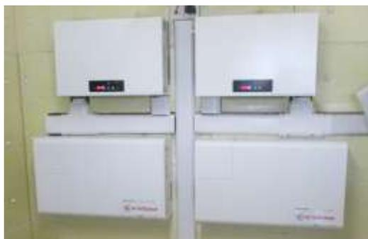
写真2 エネイースを構成するパワーコンディショナー(上段)とリチウムイオンバッテリー
