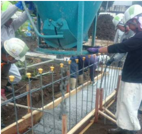
写真1「スラグリート®」打込み状況
