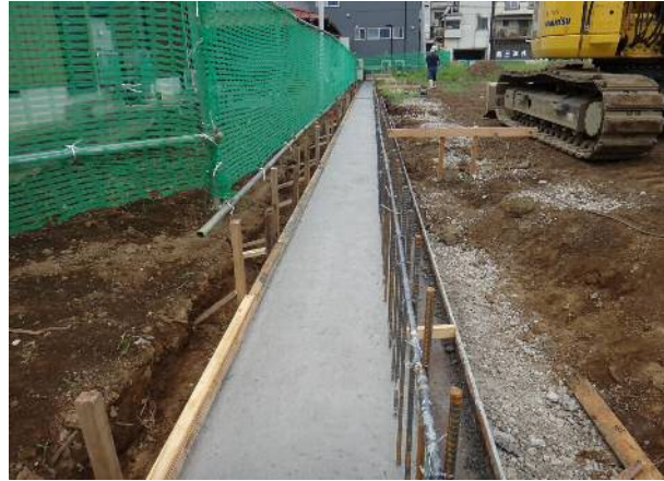
写真2「スラグリート®」擁壁底板打込み完了
