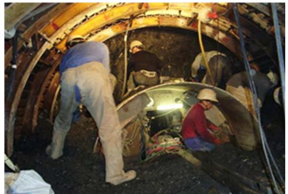
写真-1 拘束されたTBMの周囲を人力により拡幅する様子
