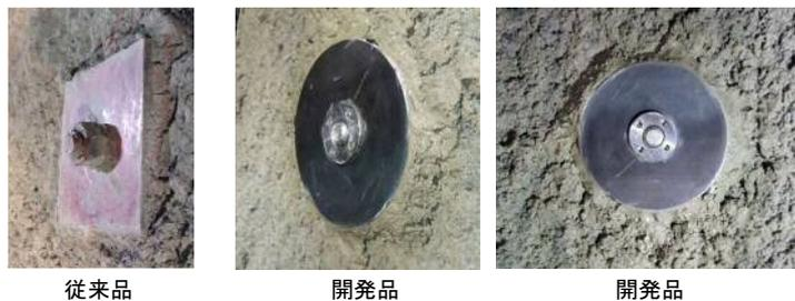
写真-3 突起レスロックボルト試験施工
