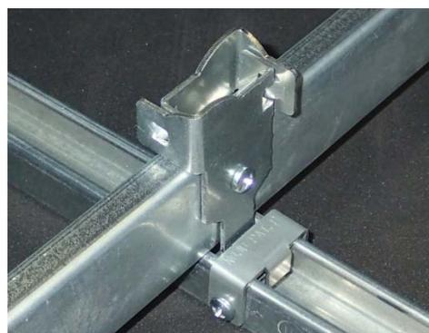
写真2 ペアロッククリップの取り付け状況
