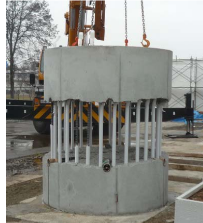
写真2 余盛撤去状況
