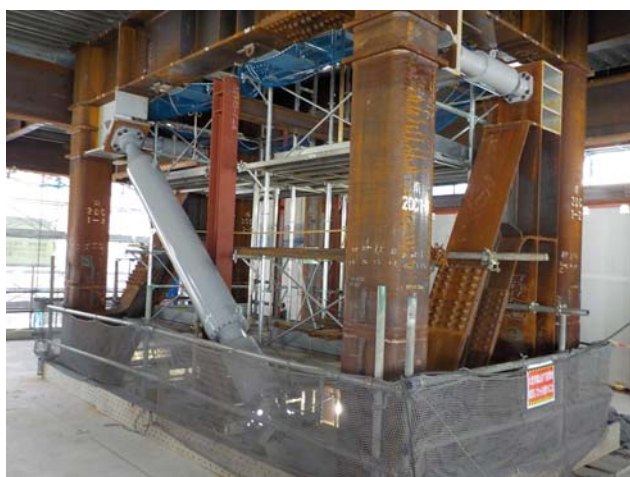
写真1 エレベータシャフト内制振フレーム (制振ダンパー集中配置)
