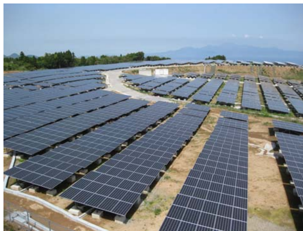
パネル設置状況
