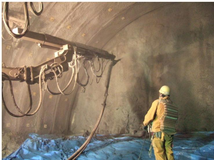
写真2 吹付けコンクリートの比較試験状況
