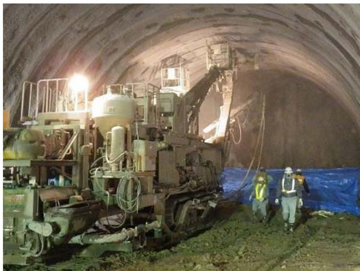
写真1 低リバウンド吹付けコンクリートの施工状況
