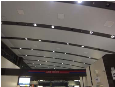
写真1 コンコース部の天井(竣工後)
