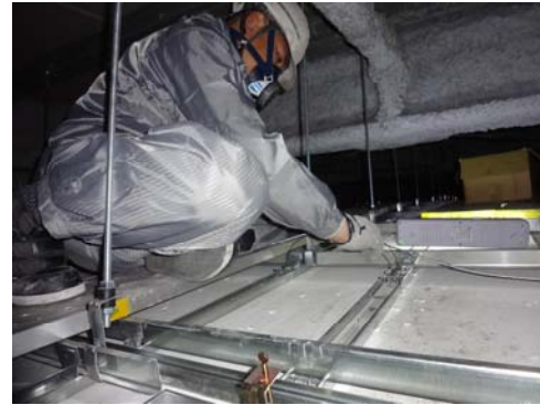
写真2 天井内での作業状況
