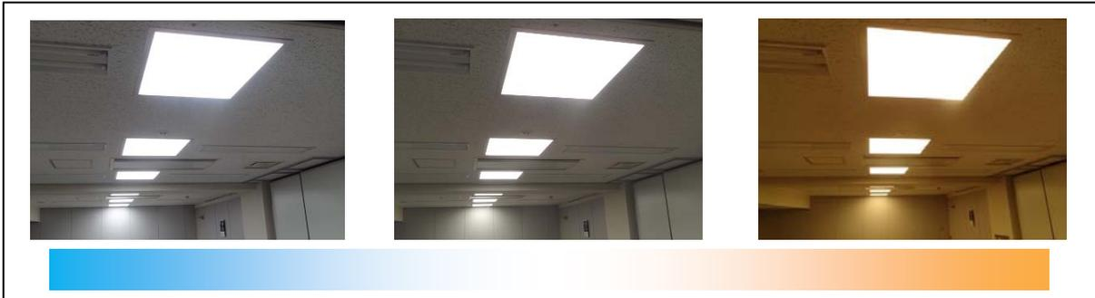
写真1 戸田建設本社ビルに設置されたスマートホスピタルライティングシステム(朝～昼～夕方を光色制御)
