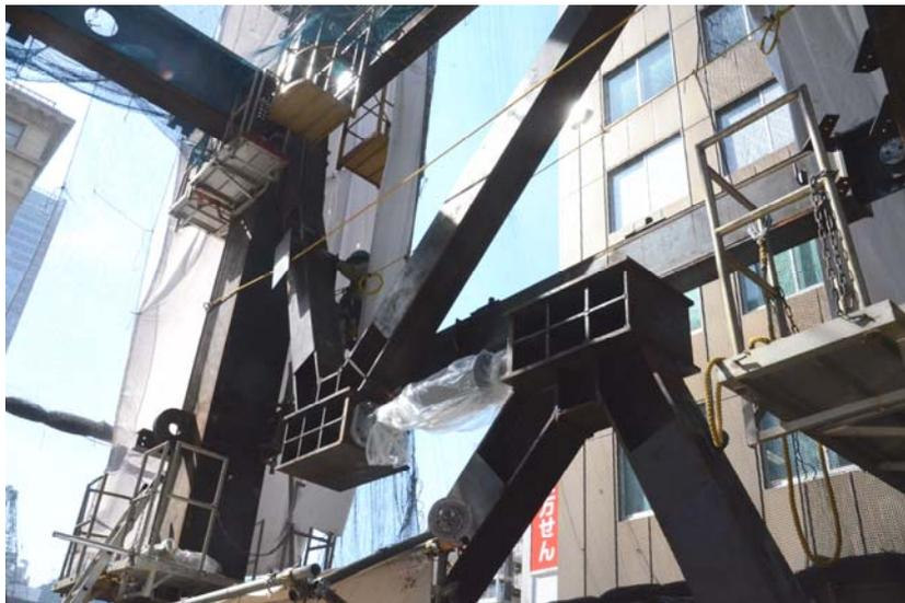
写真1 制振ダンパー設置状況
