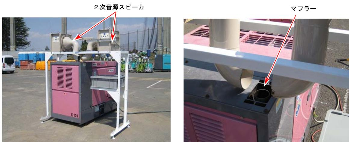
写真1 「発電機TANC（タンク）」の設置状況
