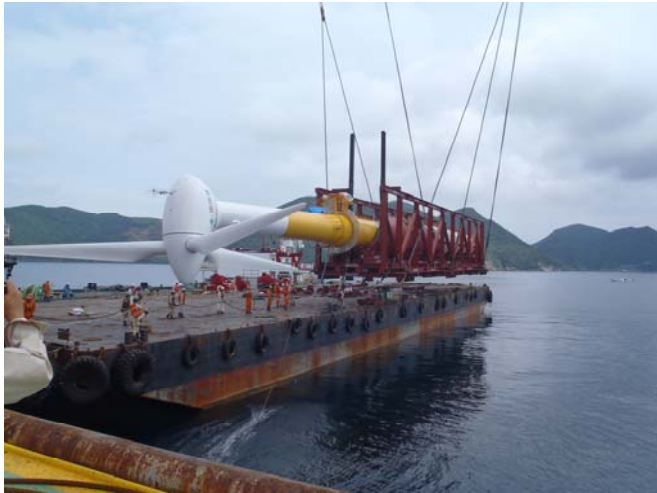
①台船からの吊上げ時
