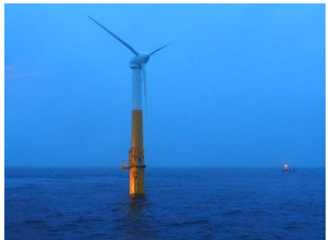
⑤所定位置での係留・設置完了時
