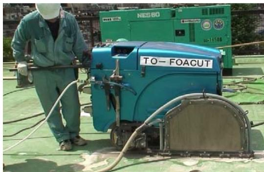
写真1 泡切断状況
