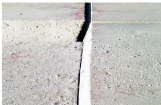
写真2 斜め切断状況
