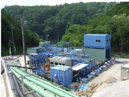
写真1 濁水処理システム
